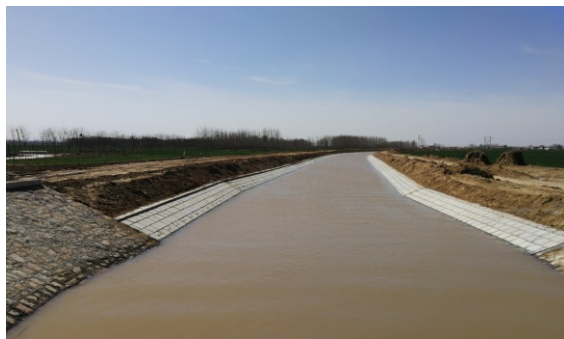
渠道衬砌8.46km，改造11.72km
